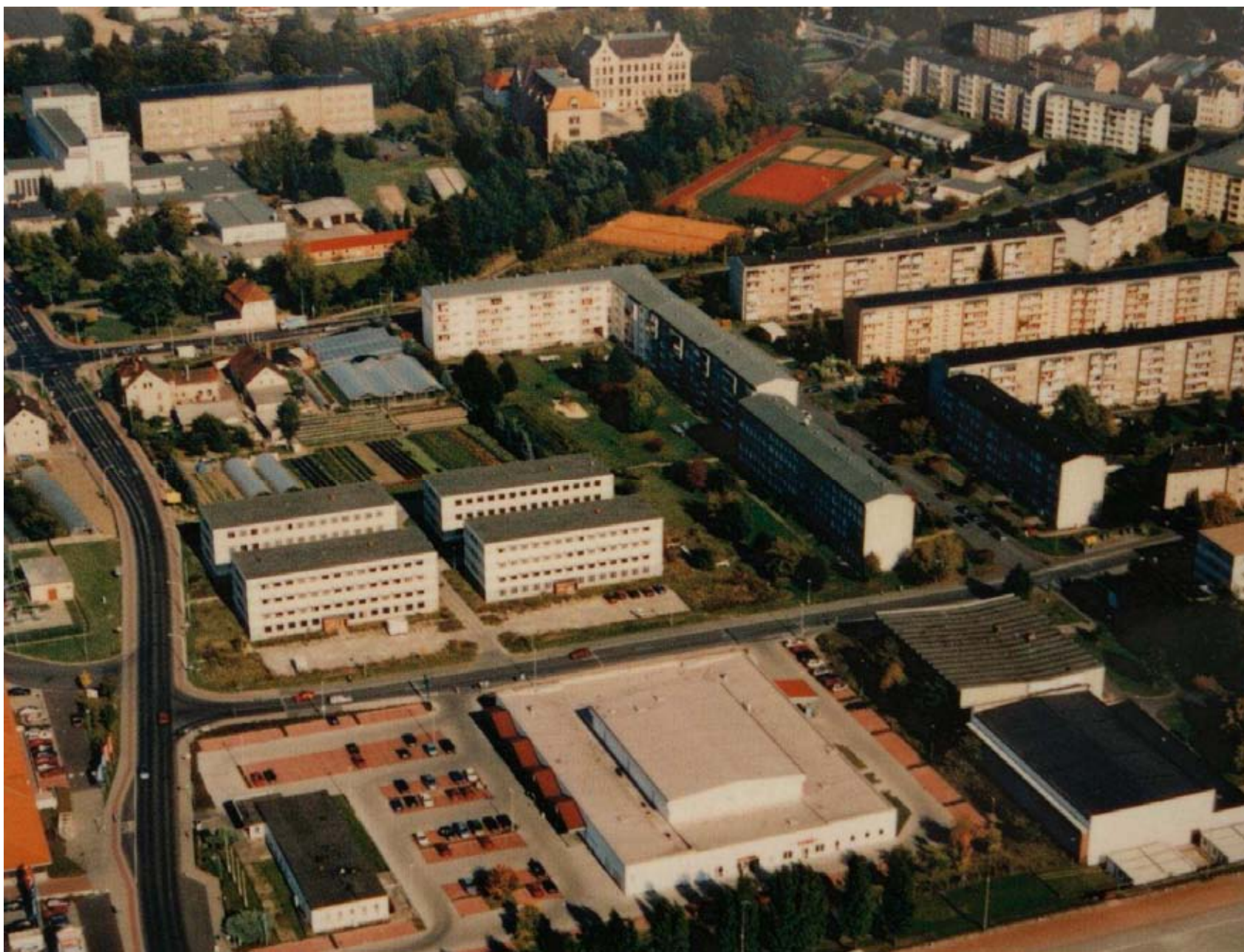
Alte Kasernen in Zittau entlang der Hochwaldstraße (vor 2009)
