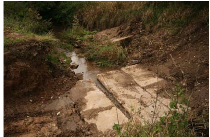
Oktober 2012 - noch heute sind Abschnitte so verbaut (Betonplatten)
