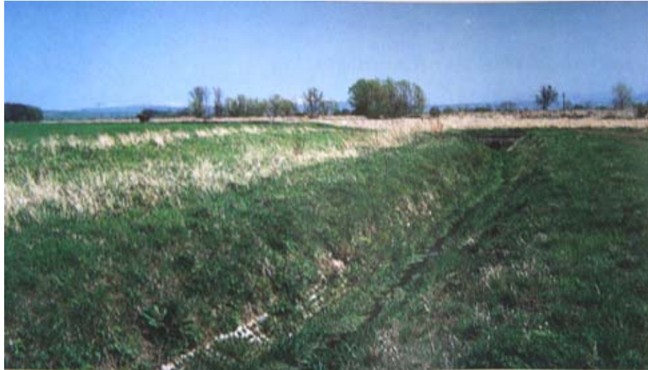
Abschnitt des Scheidebachs in den 1990ern – deutlich verbaut mit Betongitterplatten
