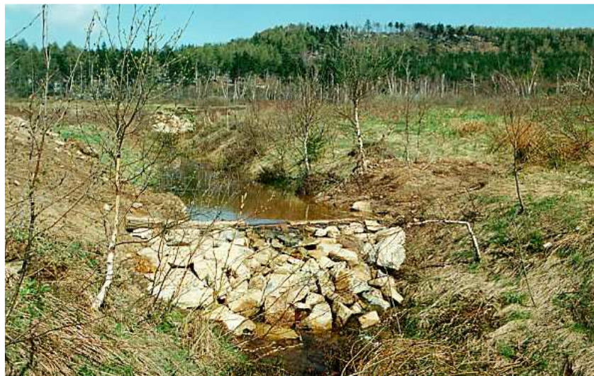
angestauter Bach zur Grundwassererhöhung
